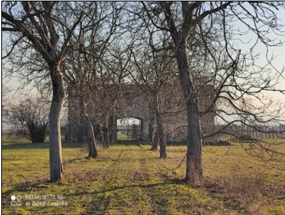
Figura 78: Casa rurale a porta morta con viale.
