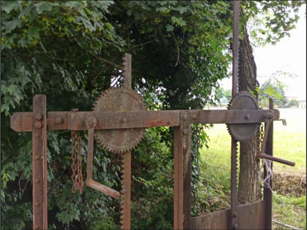
Figura 65: La “meccanica” della paratoia (particolare).
