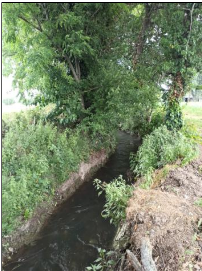
Figura 69: Acqua dell'Enza trasportata lungo la Canalina di Bibbiano per scopo d'irrigazione.
