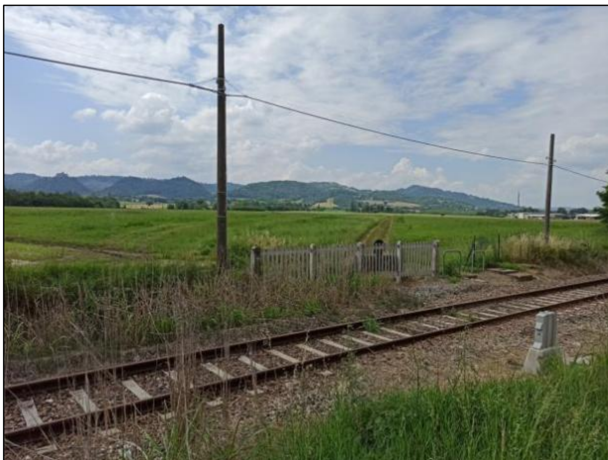
Figura 101: Il tracciato della ferrovia Reggio-Ciano, confine sud-est della SPT.
