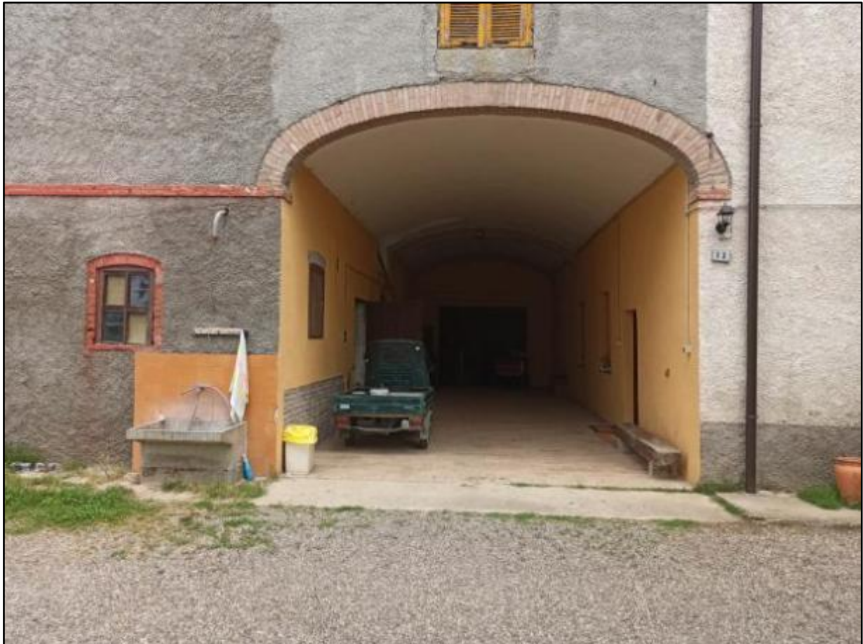
Figura 89: Tradizionale casa a “porta morta” con ingresso dall'aia-cortile posta a sud.
