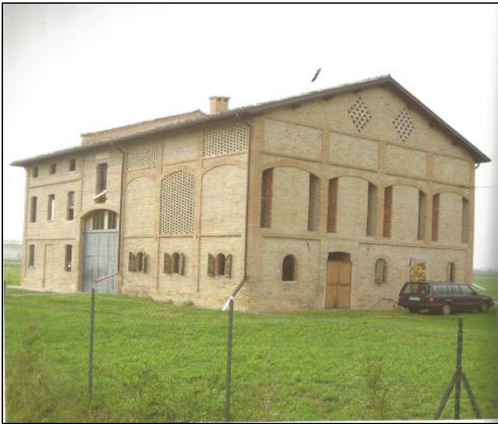
Figura 77: Casa rurale Via Ariosto.
