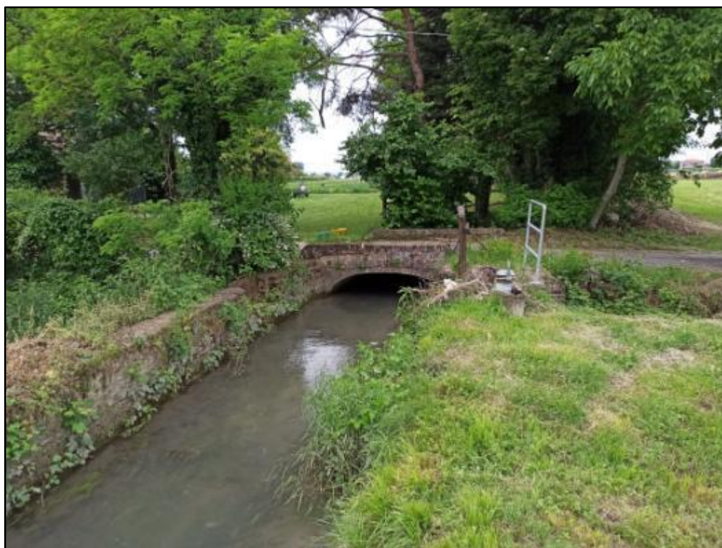
Figura 70: Stradello rurale sovrappassa la Canalina di Bibbiano.
