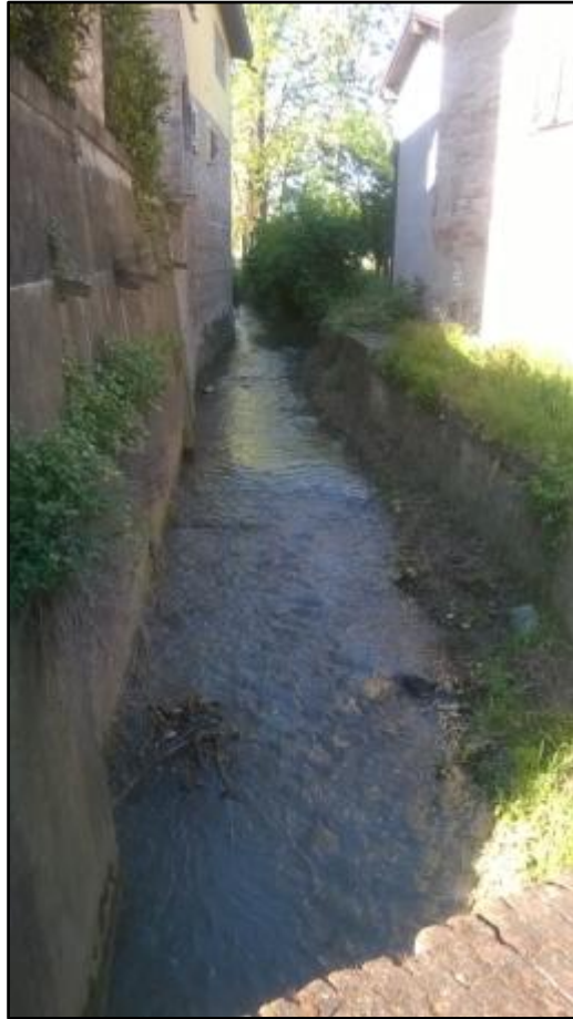
Figura 73: Borgo rurale con canale irriguo ad uso promiscuo scolante.
