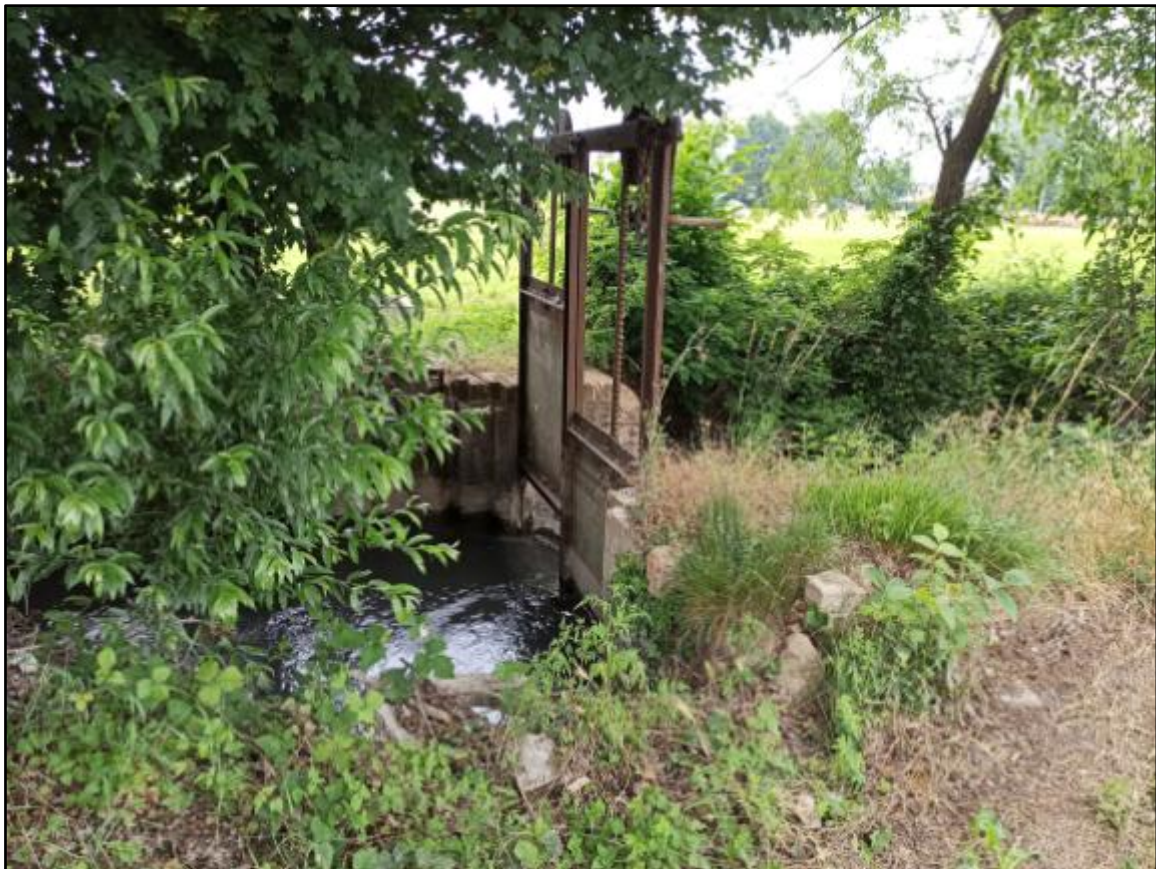
Figura 62: Chiavica secolare con grande paratoia lungo la Canalina di Bibbiano.
